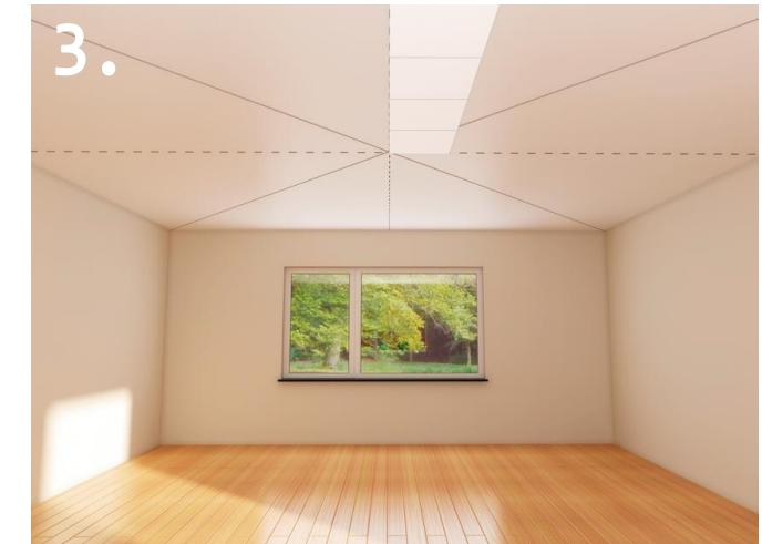
Stropní desky pokládejte v pravém úhlu ke stěnám, přičemž okraj desky začněte pokládat od středu stropu. Další desky lepte v řadách. Stropní desky s označením na zadní straně se ukládají ve stejném směru.
