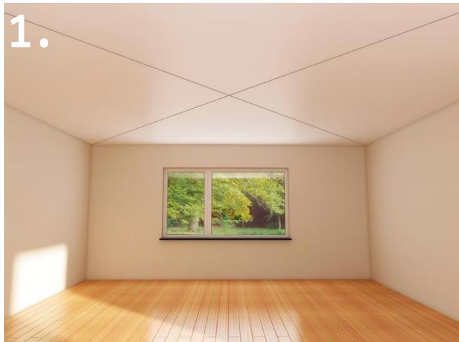
Podklad musí být suchý, pevný, nemastný a bezprašný. Najděte střed stropu tak, že napnete dva provázky diagonálně od jednoho rohu k druhému.
