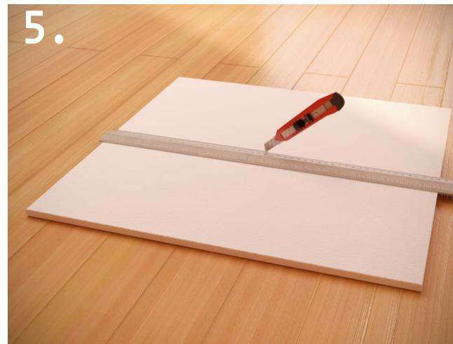
Stropní desky můžete upravit na požadovaný rozměr pomocí olamovacího nože.
